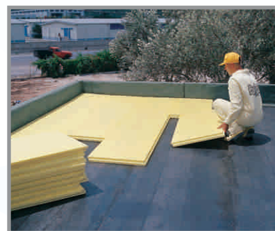
укладка теплоизоляции
