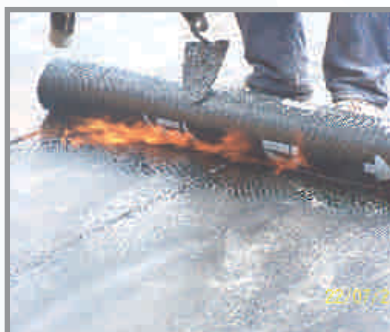
наплавка гидроизоляции
