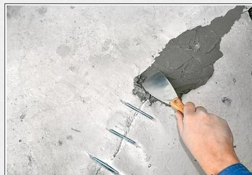
1.6 Устраните все острые выступы, углы и т. д., для этого изготовьте переходные галтели или выкружки (обычно из цементно-песчаного раствора марки не ниже М150, размер галтели должен быть ~ 100x100 мм.)
